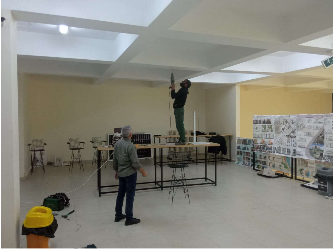
Ek 1: Yükseklięi ayarlanabilir projeksiyon askısı montajı işlemlerine ait fotoęraflar.
