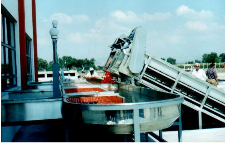
Resim 1.1: Salça üretim fabrikalarında ön yıkama ünitesi
